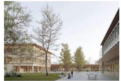
Schulstandort Hohewart 2 in Stuttgart-Feuerbach
